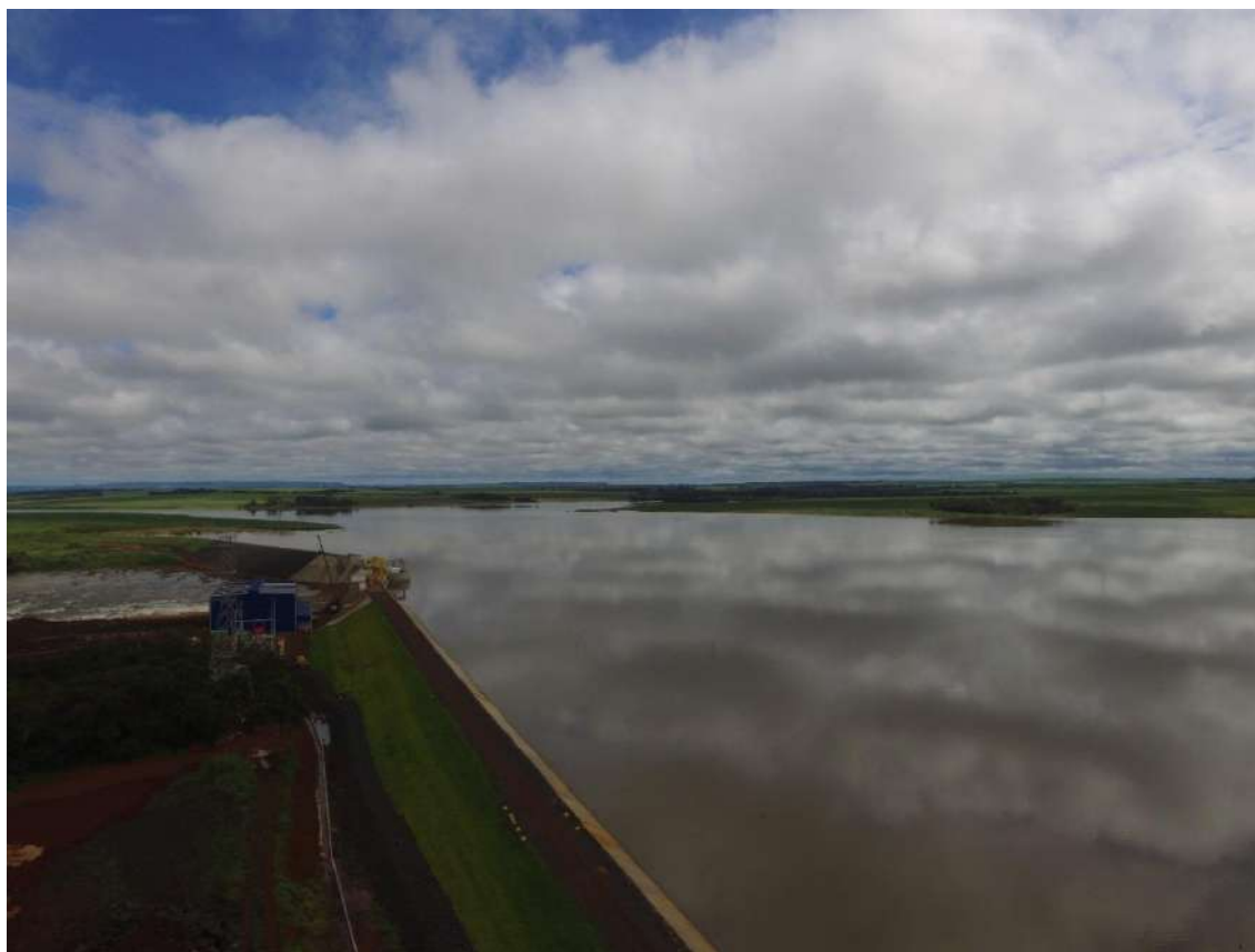
Figura 22. Reservatório Artificial da PCH Verde 08 após conclusão do enchimento.
