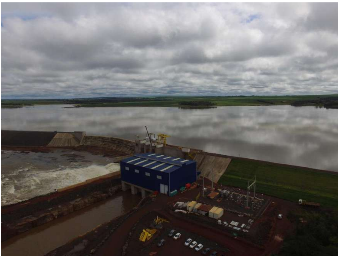
Figura 20. Reservatório Artificial da PCH Verde 08 após conclusão do enchimento.
