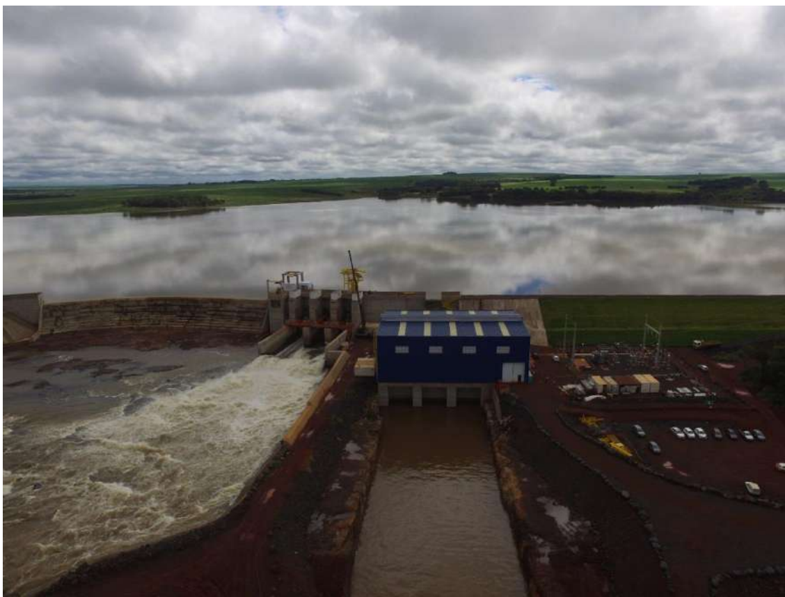
Figura 21. Reservatório Artificial da PCH Verde 08 após conclusão do enchimento.
